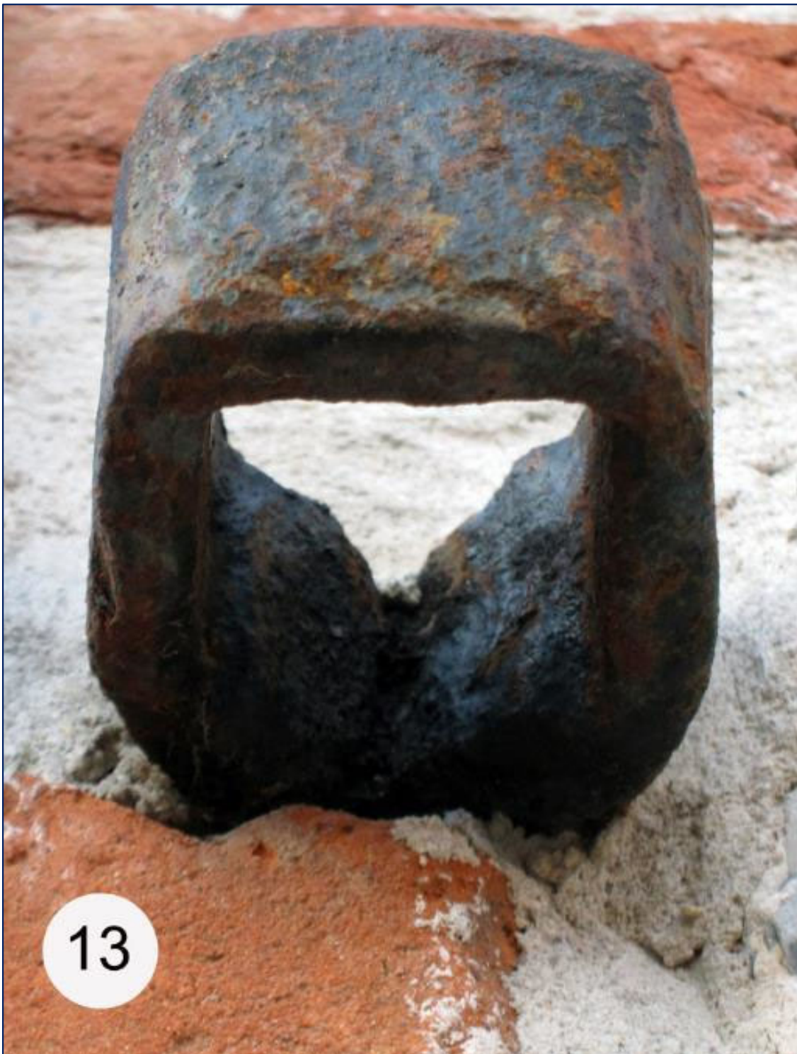
Coupe de l'œillet d'un tirant.
